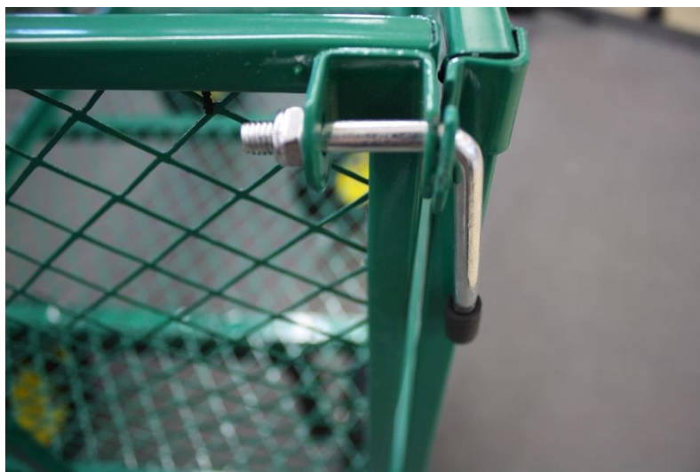
Ilustracja 6: Mocowanie "L-screw"
