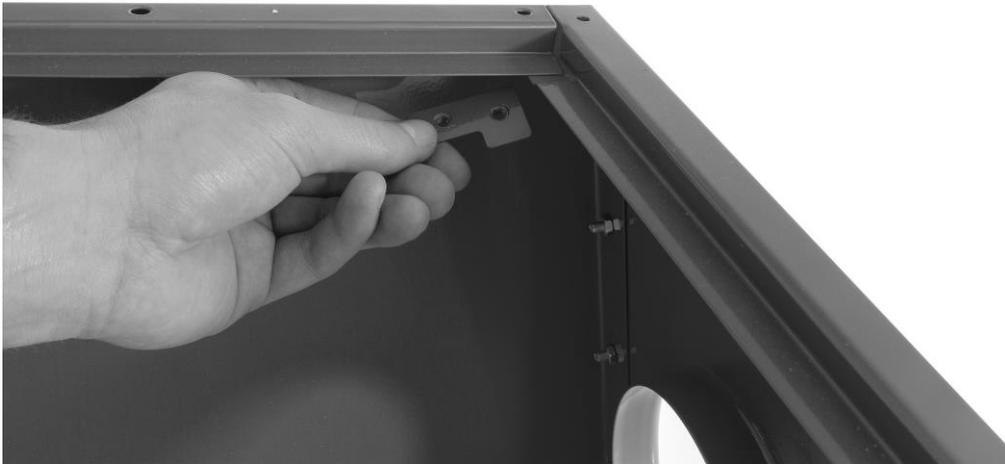
Abbildung 3: Befestigung der Winkel
