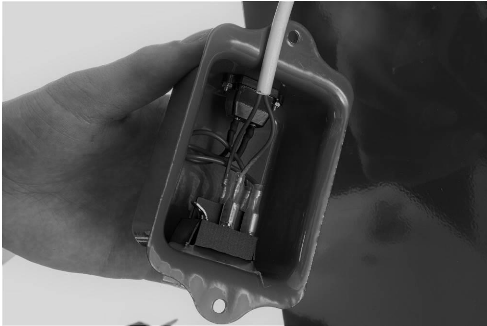
Figur 15: Tilslutning af kablet til kontakten
