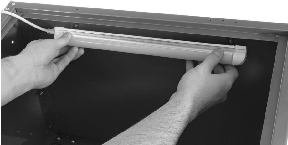
Figur 10: Installation af lysstofrør
