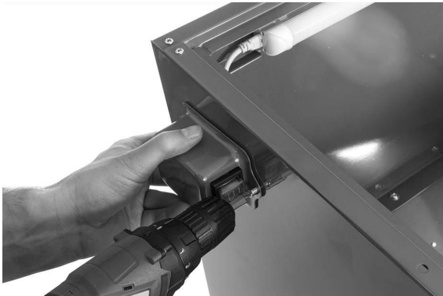
Figura 11: Desmontaje de la caja de encofrado
