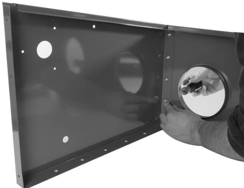
Figura 2: Fijación de los paneles laterales
